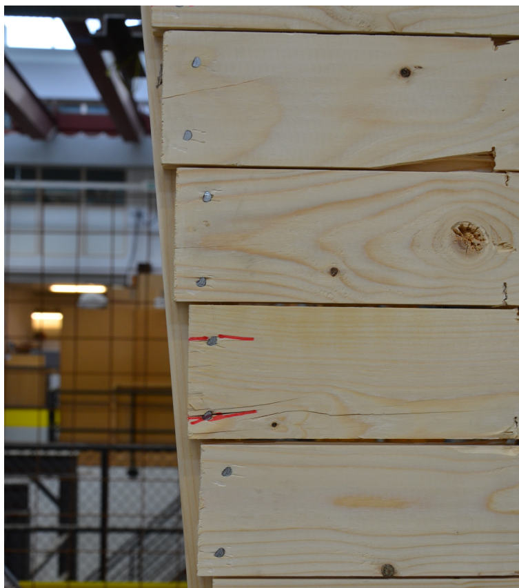
Figur 5.8: Skjuvdeformation mellan brädor i en provkropp av typ III.
