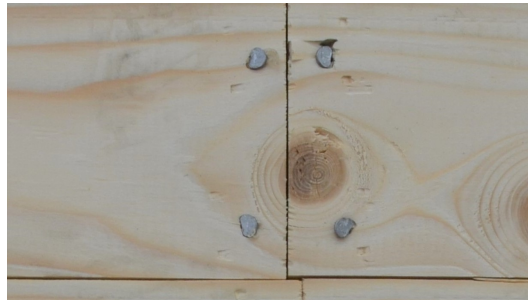
Figur 3.5: Närbild på dubbelspikat förband.
