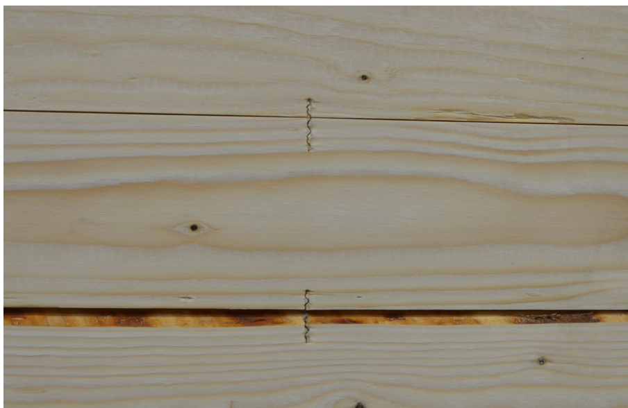
Figur 3.1: Närbild på stiften som kopplar samman brädorna i en råspontlucka.
