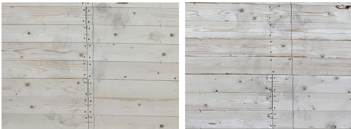
Figur 3.3: t.v. generalskarv med dubbelspikade förband över mittregel. t.h. överlappsskarv med varannan lucka med dubbelspikad skarv över mittregel.
