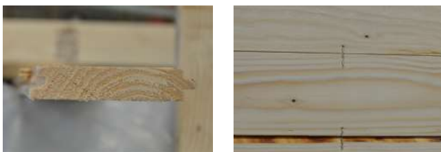
Figur 1: t.v. en råspontbräda med not och fjäder. t.h. närbild på stiftet som kopplar samman brädorna i en råspontlucka.
