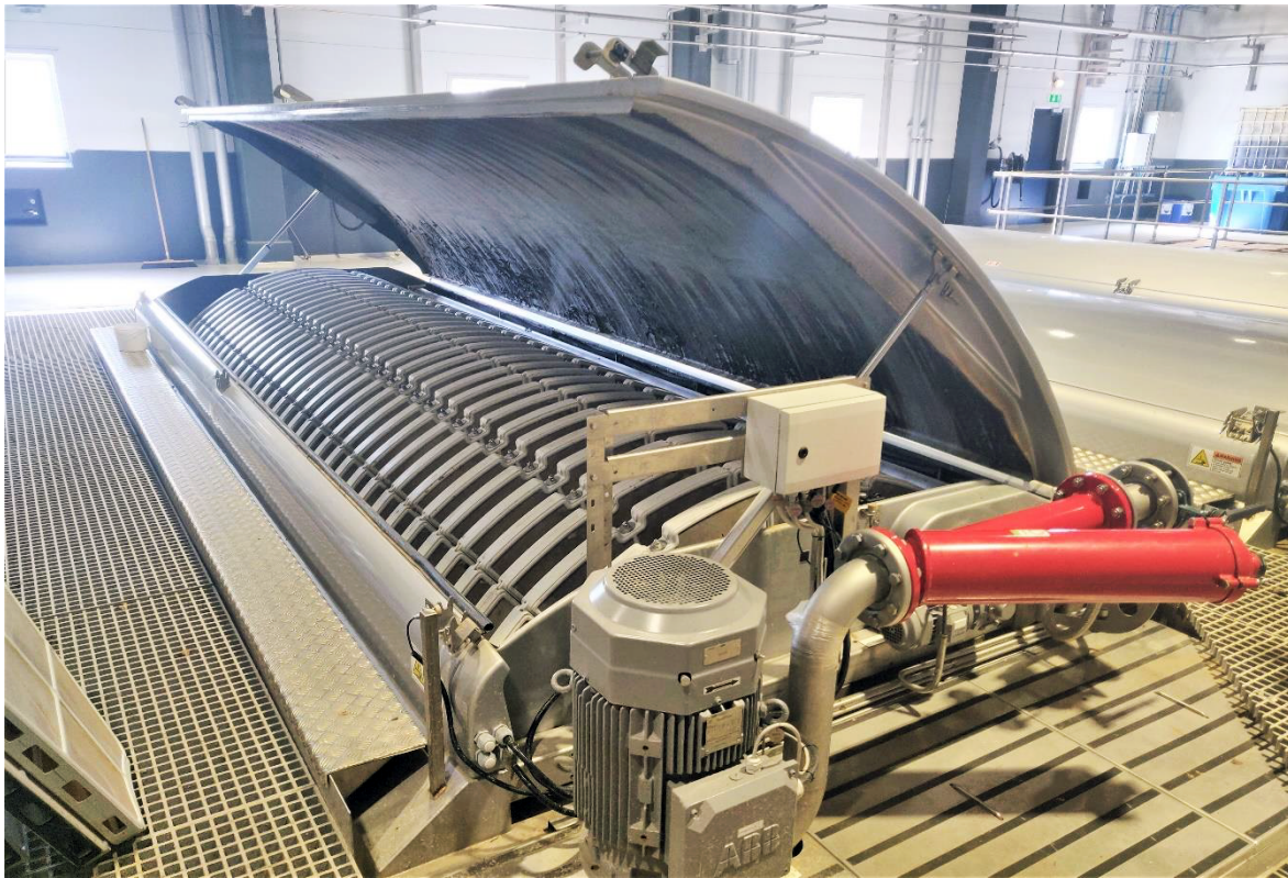
Figur 6. DynaDisc-skivfilter från Nordic Water.
