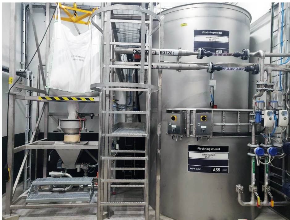
Figur 5. Polymerberedningen på SCM. Till vänster: säck med torrt polymergranulat. Upppe till höger: beredningstank. Nere till höger: doseringstank.
