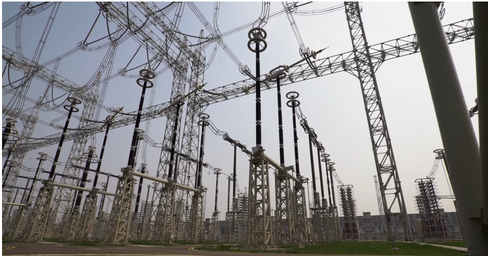
Figur 17: Luftisolerat högspänningsställverk utomhus, från (ABB 2019a) med tillåtelse från ABB.
