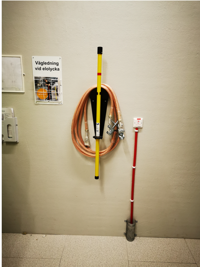
Figur 10: Jordningsdon i tågdepån i Hässleholm.
