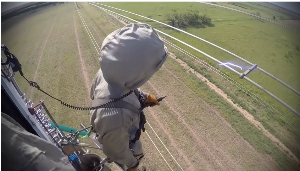
Figur 4: Arbete med spänning från en helikopter, från (White 2016).
