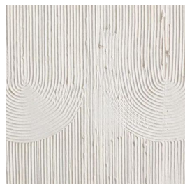
kalkputs med tydlig penselstuktur
