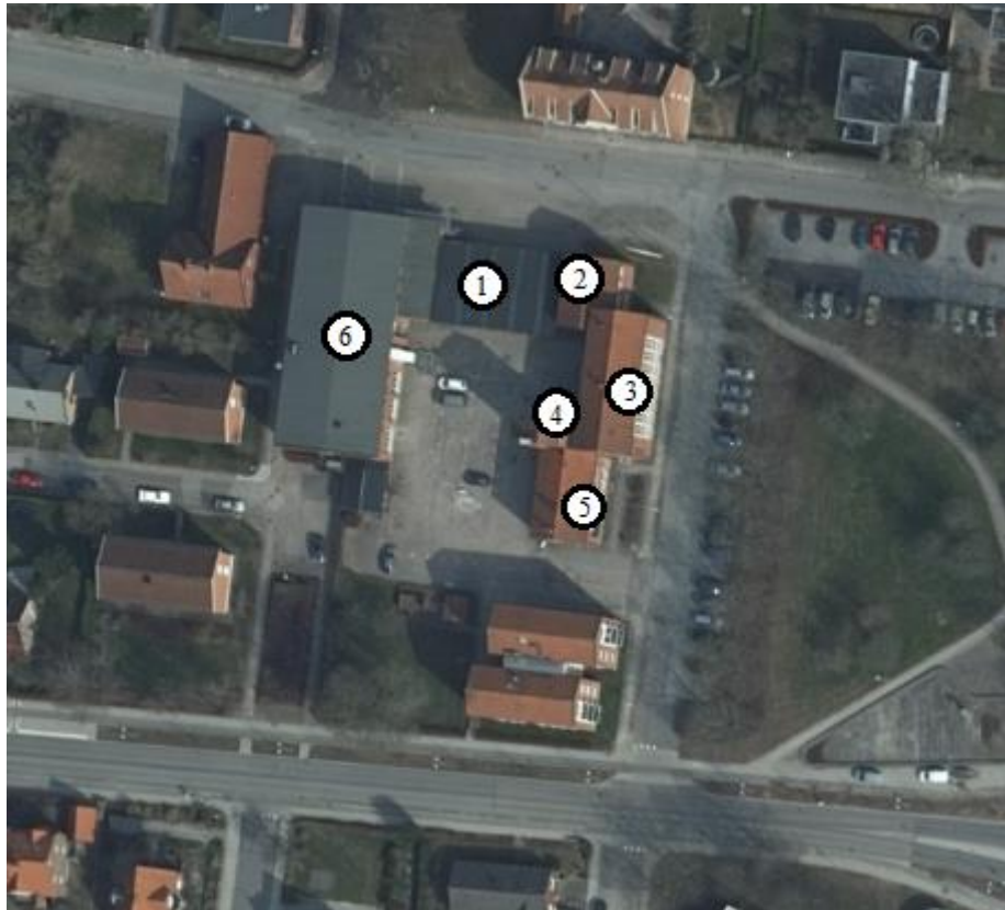
Figur 3. Översiktlig bild över fastigheten Kastanjen 1. Byggnaderna utgörs av en vagnhall (1), lokal- och kontorsbyggnader (2 och 3), slang- och övningstorn (4), bilverkstad (5) samt vagn- och tvätthall (6). Bild modifierad från ©Lantmäteriet.
