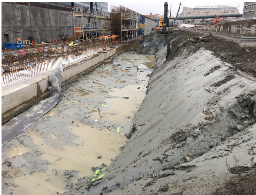
Figur 4.1: Slänt i lera på referensprojektet, copyright Anton Gunnebrink (2020)
