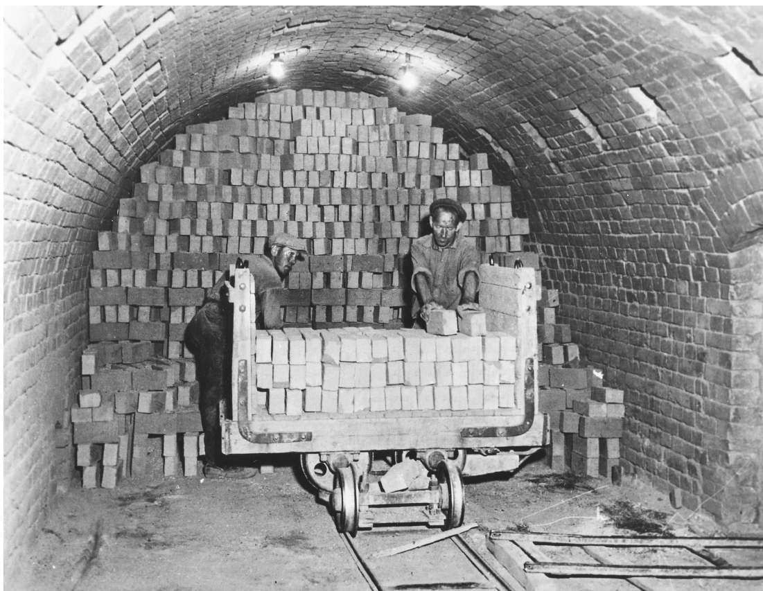
Fig. 15. Interiör i tegelugn av typen ringugn. Fittja Tegelbruk 1946.
