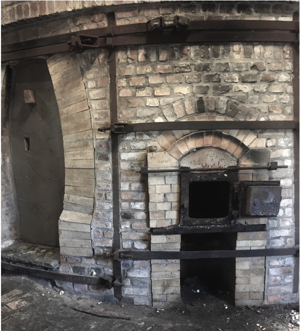
Fig. 16: Keramikugn av periodisk typ, Wallåkra Stenkärlsfabrik 2018. Sättöppningen t.v. i bild är kallmurad och rappad.
