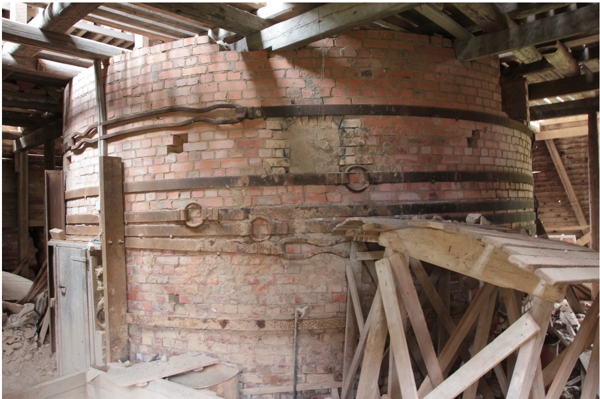
Fig. 11. Den gamla brännugnen vid Bältarbo tegelbruk i Dalarna är av periodisk typ. Tegelbruket utsågs till årets industriminne år 2000.
