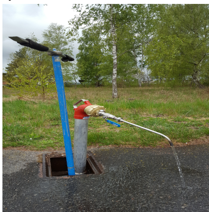
(c) Brandpost, delar monterade och ventilen till brandposten öppnad med nyckel och skaft.
