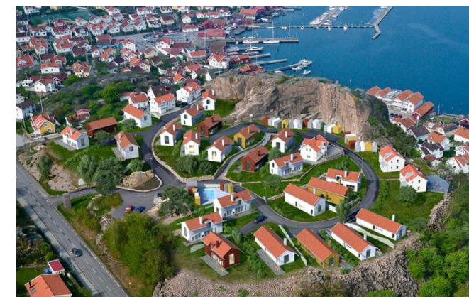
Nytt bostadsområde på Korpäsberget, Wingårdh Arkitekter. Ingreppet i berget är ett tidigare resultat av stenindustrin. Siluettpåverkan är relativt låg i och med att berget är intakt mot havet, men proportioner och placering av husen kan diskuteras.
