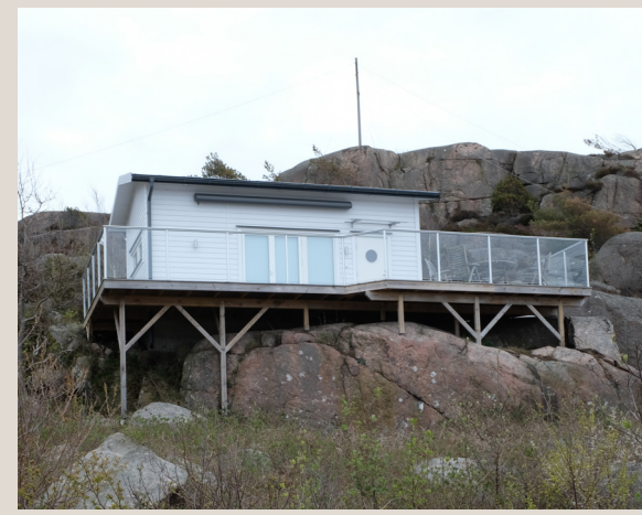
En mindre sommarbostad är anlagd en bit upp på Gullviksberget. Hus med terrass möter landskapet med ett antal mindre nedslag. Träpelare, som anpassats i längd och placering.
