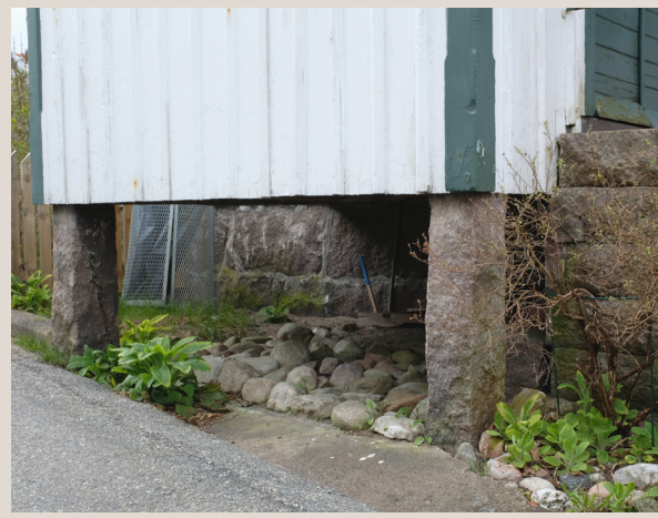
Flera exempel finns där pelare i granit hjälper till att bära delar av husen. Här ser vi ett bostadshus i Bovallstrands kärna, där pelarna i princip ansluter till den publika gatan.
