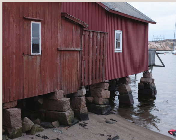
Många av de äldre sjöbodarna står än idag kvar längst ortens strandlinje. På bilden ser vi det typiska sättet att plinta upp huset från land och ut i havet.
