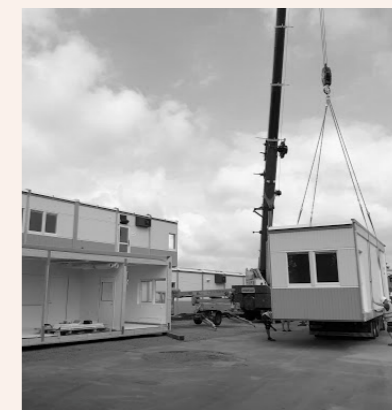
Moduler lyfts. Foto: Janssons Bygg 11
