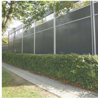
Plåtfasad åt väster i nytt utförande.
