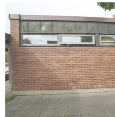
Typfasad för den södra delen av byggnaden med takavslut i brunlackad plåt, kopparplåt, smala fönsterband med fönsterbågar i trä, tegelfasad och sockel i betong.
