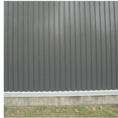
Plåtfasad och övergång till sockel i betong.
