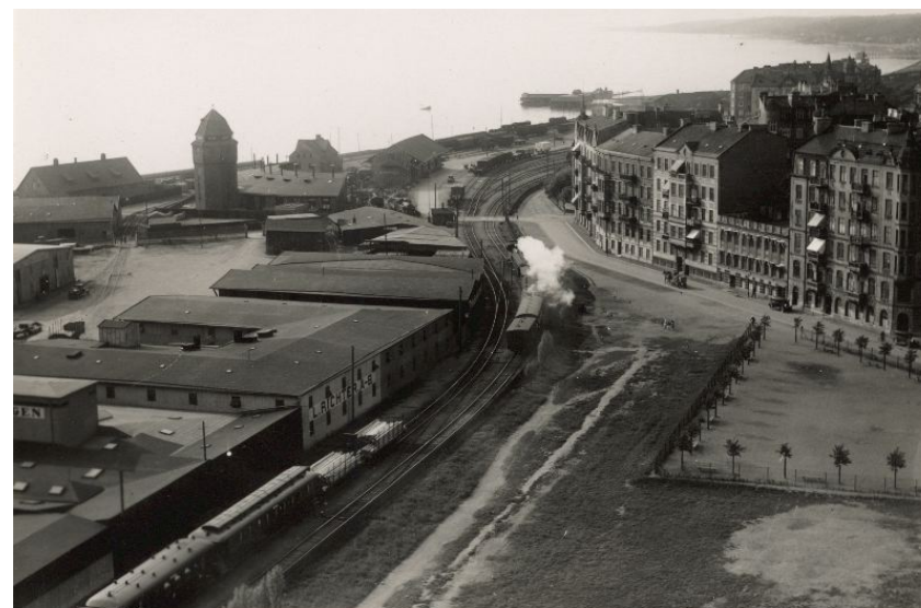
Järnvägen var länge en barriär mot havet. Bild från 1930-talet. Bildkälla: Helsingborg stad
