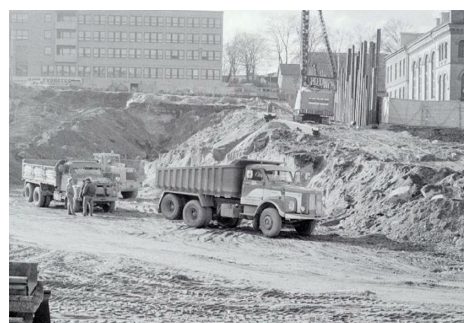
På den här bilden från bygget av Lunakvarteret får man en bra bild av de stora ingrepp i landskapet som krävdes.
