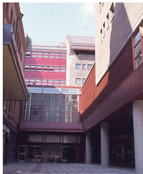
Entrén till Lunagallerian strax innan färdigställandet.
