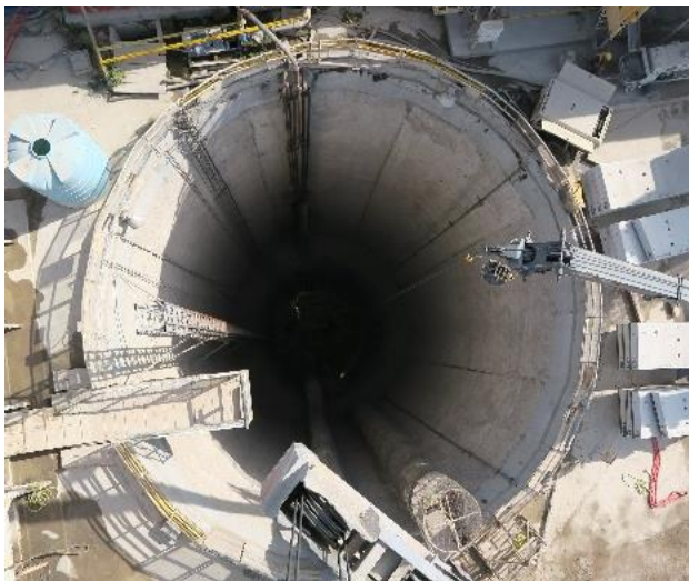
Figur 1. Vertikalt schakt med cirkulär plangeometri.
