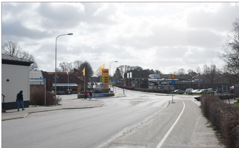
Dalbyvägens utbredning vid biblioteket, bensinstationen och Konsums parkering. Källa: Egen
