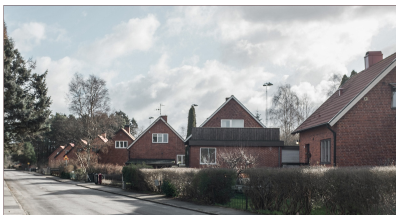
Sammanhållen tegelbebyggelse Källa: Egen
