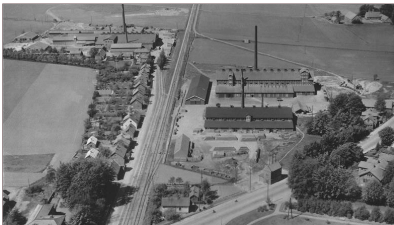
Tegelbruken och järnvägen Källa: Veberod.nu
