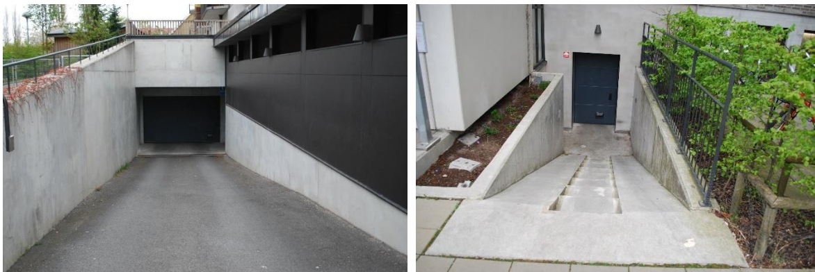
Figur 54. Ramp ner till bilgarage (vänster) och till cykelrum (höger).
