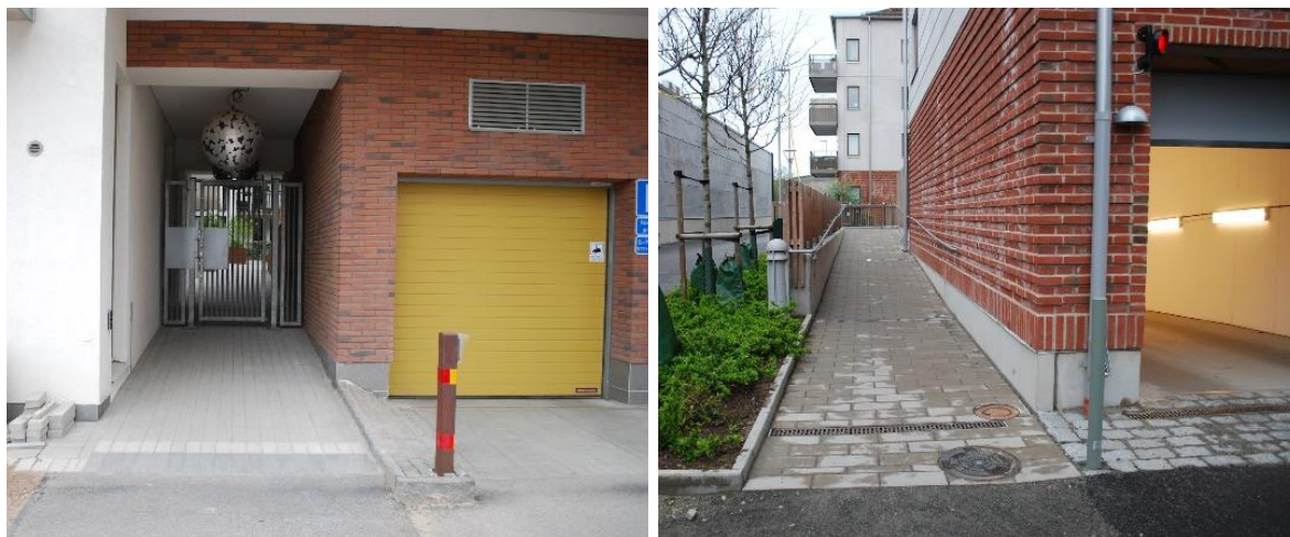
Figur 11. Ramper till innergård på Torrissen (vänster) och innergård på Trådbussen (höger).
