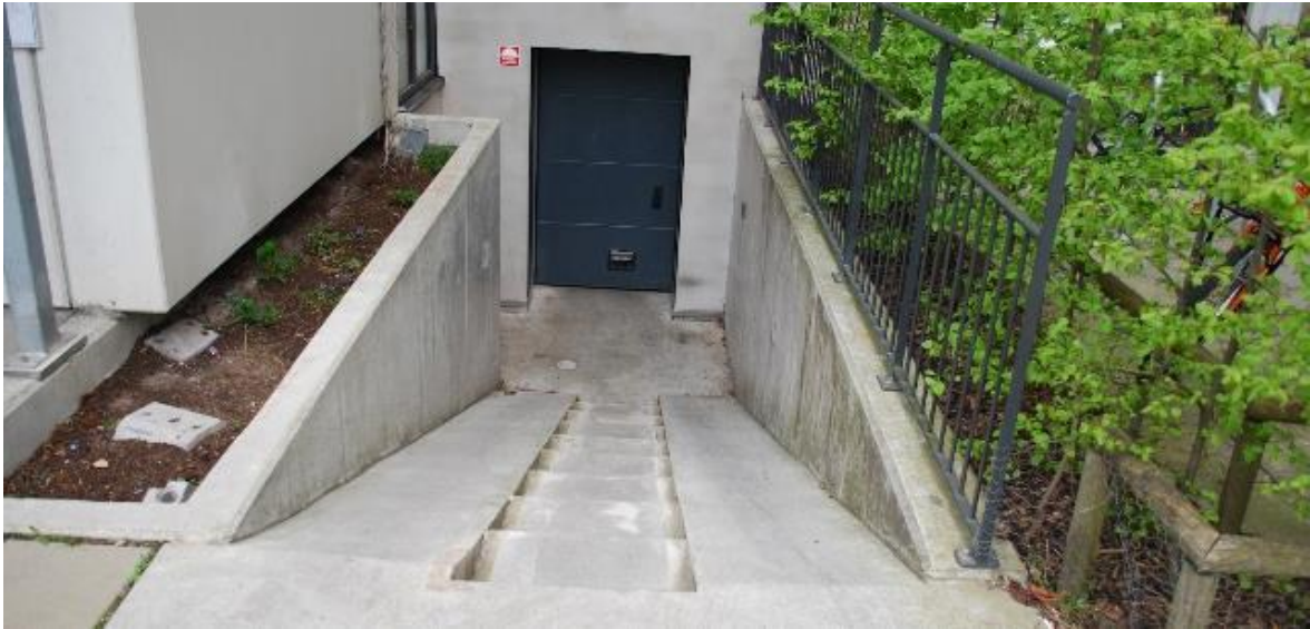
Figur 12. Ramp till cykelförråd i källaren på Greenhouse Augustenborg.
