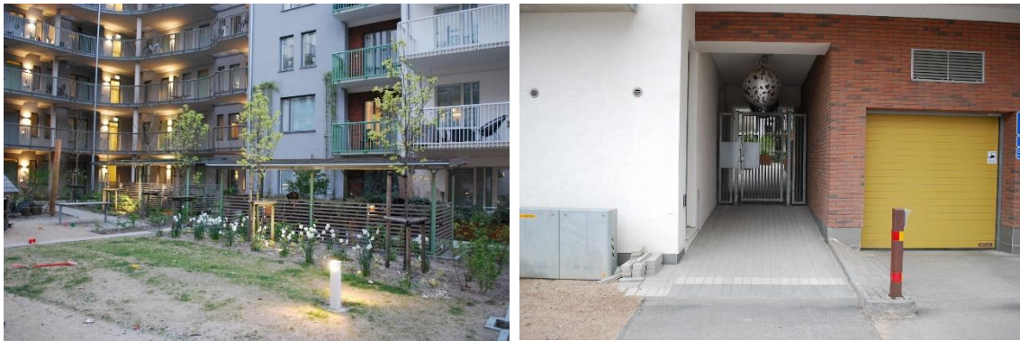
Figur 26. Vy över väderskyddad parkering från innergård (vänster) samt entré till innergård och källare (höger).
