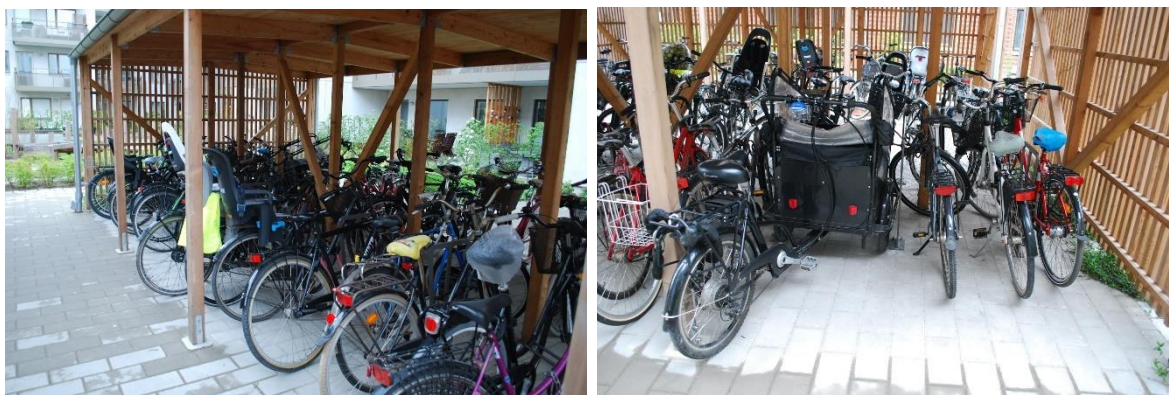
Figur 39. Väderskyddad cykelparkering på innergård.
