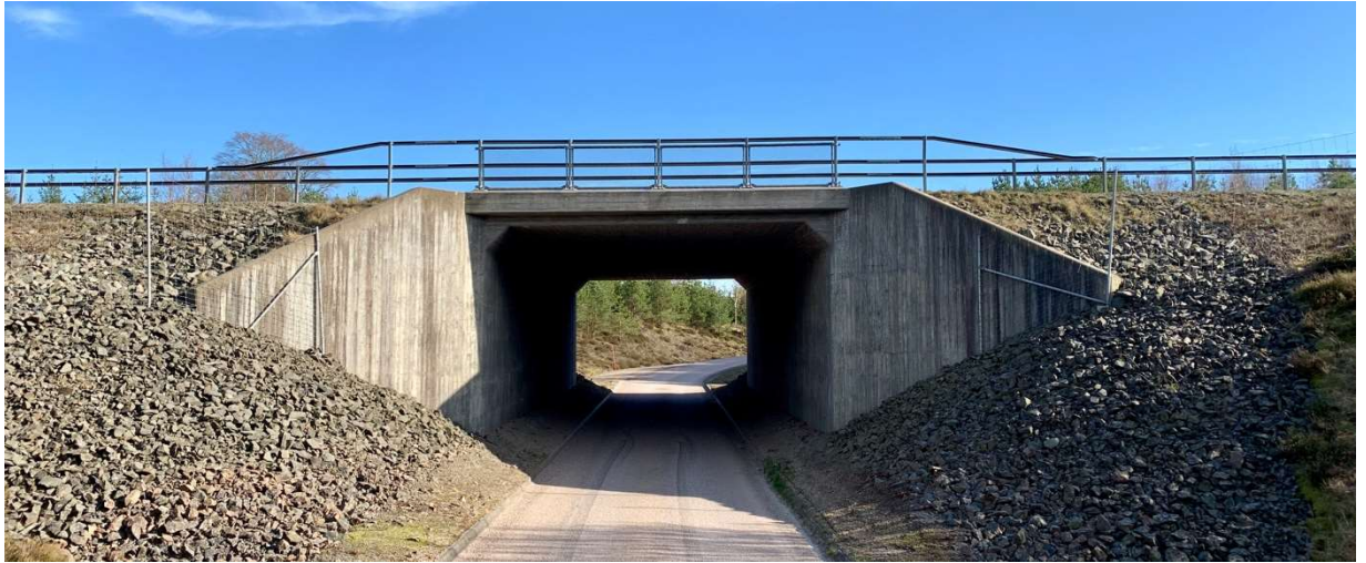
Figur 2.1 Plattrambro vid möte mellan landsväg och motorväg.
