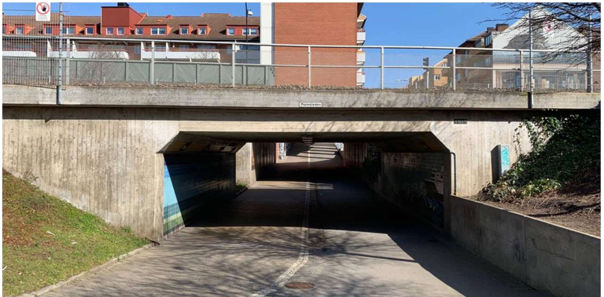
Figur 2.2 Plattrambro där gång- och cykelväg korsar järnvägsspår.
