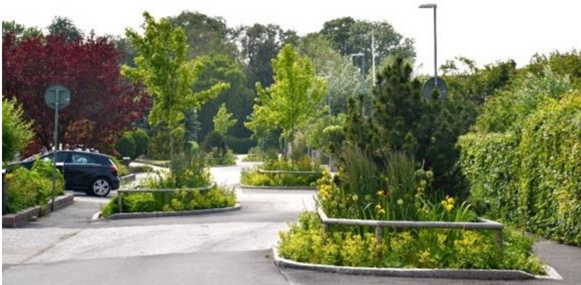
Figur 5 - En gata vars hastighet dämpats med hjälp av planteringar som tvingar både cyklister och motorfordon att sänka hastigheten, (Linde, 2019)
