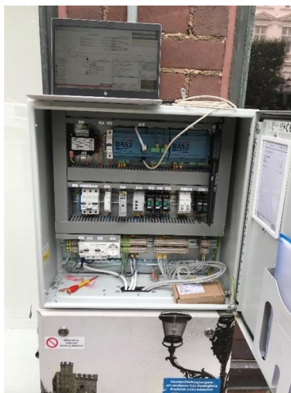
Figur 26: Elskåp med DUC installerad
