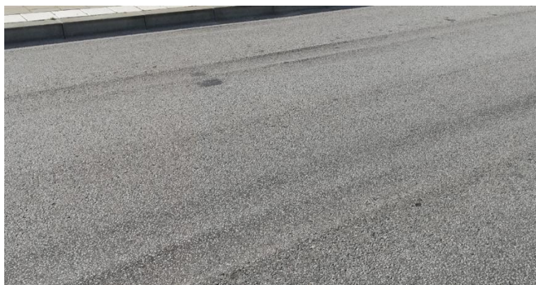
Figur 7 - Plastisk deformation till följd av linjetrafik. Foto: Benjamin Anderhorn
