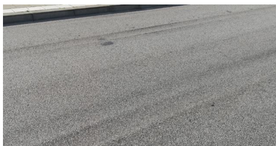
Figur 1 - Plastisk deformation. Foto: Benjamin Anderhorn
