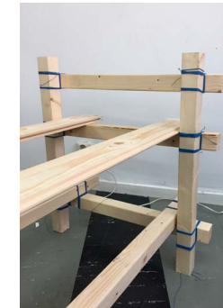
Råsponten, som blir sittyta, läggs på sist.
