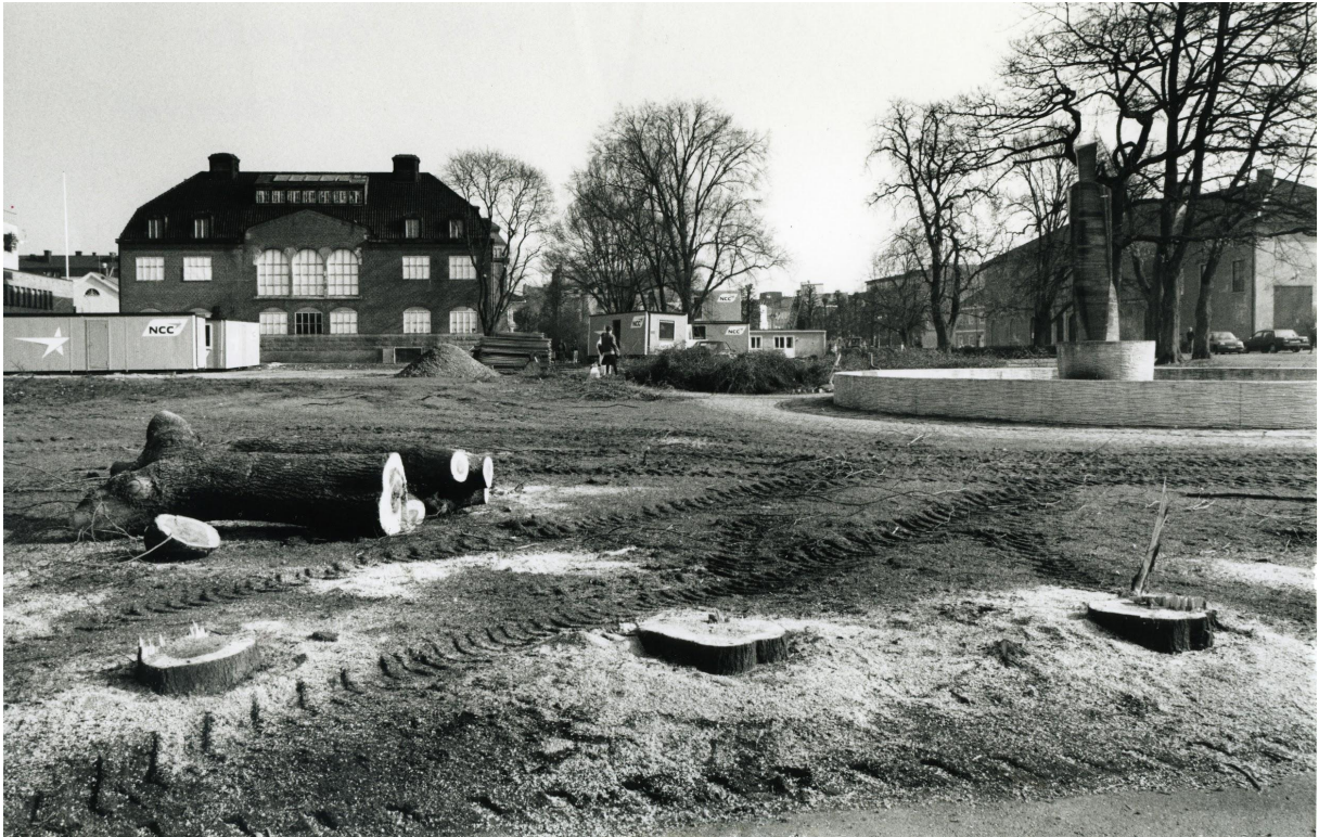
Bild 3: Förberedelser inför byggnationen av konserthuset, hotellet och konsthallen pågår.
