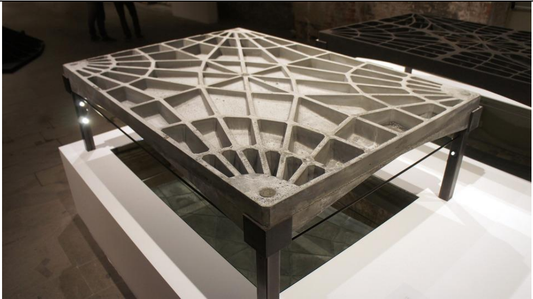
Figur 3. Exempel på optimerad utformning av prefabricerat betongbjälklag. Copyright ETH Zurich / Block Research Group, photograph by Nick Krouwel.
