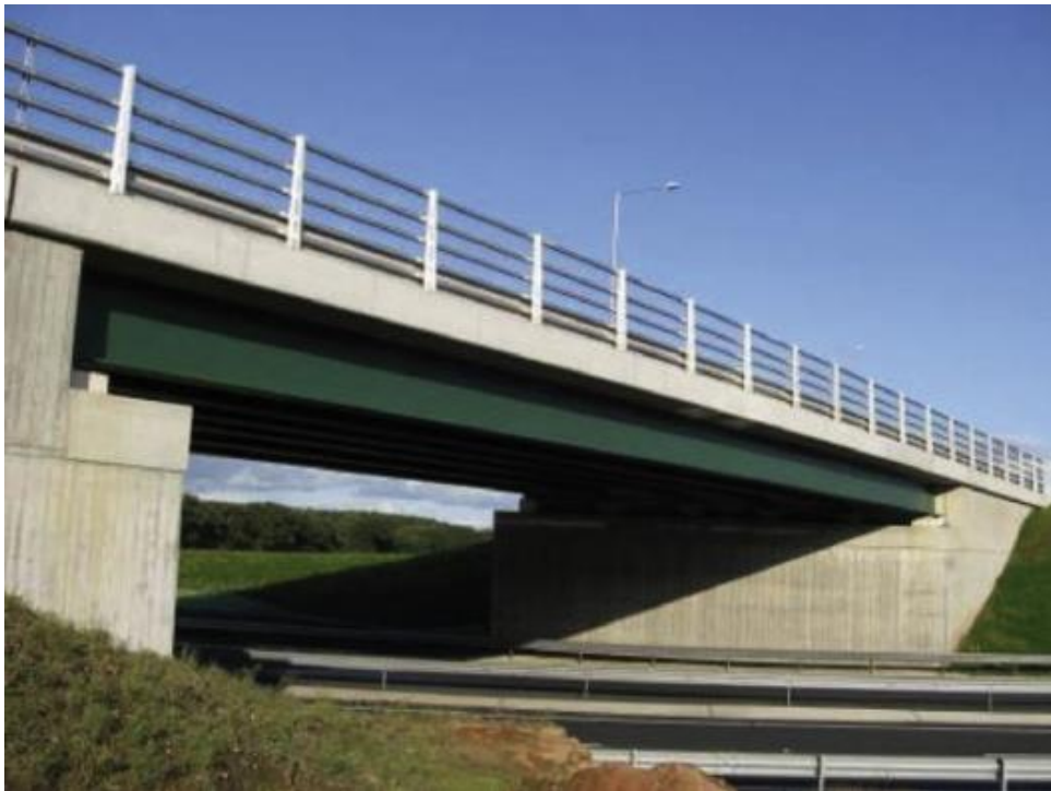
Figur 2: En typisk samverkansbro med spännvidd 30m över motorväg A1 i England [4]
