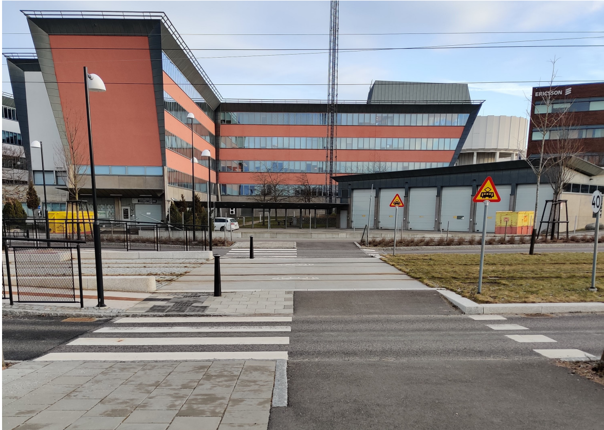
Figur 2.19: Den icke-signalreglerade övergången vid hållplats Telefonplan.
