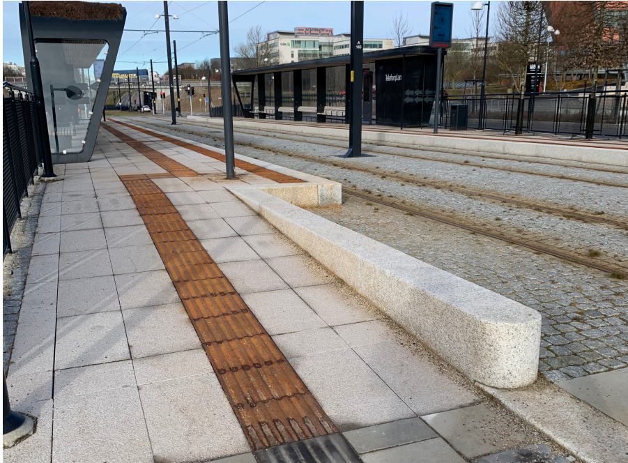
Figur 2.11: En högre kantstensvisning av vita linjen ( limpan ) för att leda trafikanterna till övergången vid hållplats Telefonplan.
