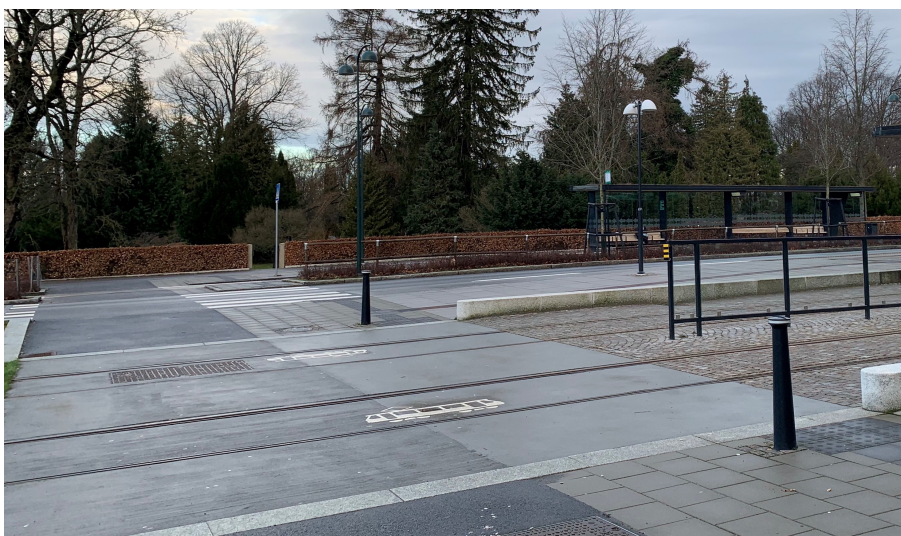
Figur 2.12: Markering av spårvagn i marken, olika markbeläggning samt pollare vid övergångens mynning. Fotografi taget vid Universitetssjukhuset.
