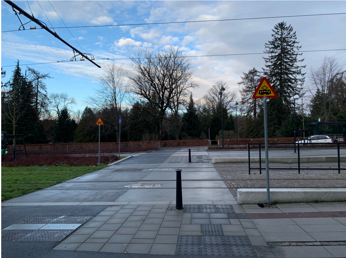
Figur 2.15: Den icke-signalreglerade övergången vid hållplats Universitetssjukhuset med vägmärke A37, varning för korsning med spårväg utan bommar.
