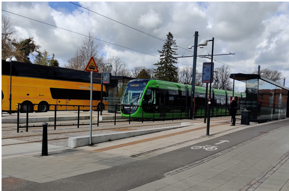
Figur 2.14: Hållplats Universitetssjukhuset där staket mellan spåren finns och bussar angör på västra sidan om plattformen och spårvagn på östra sidan.
