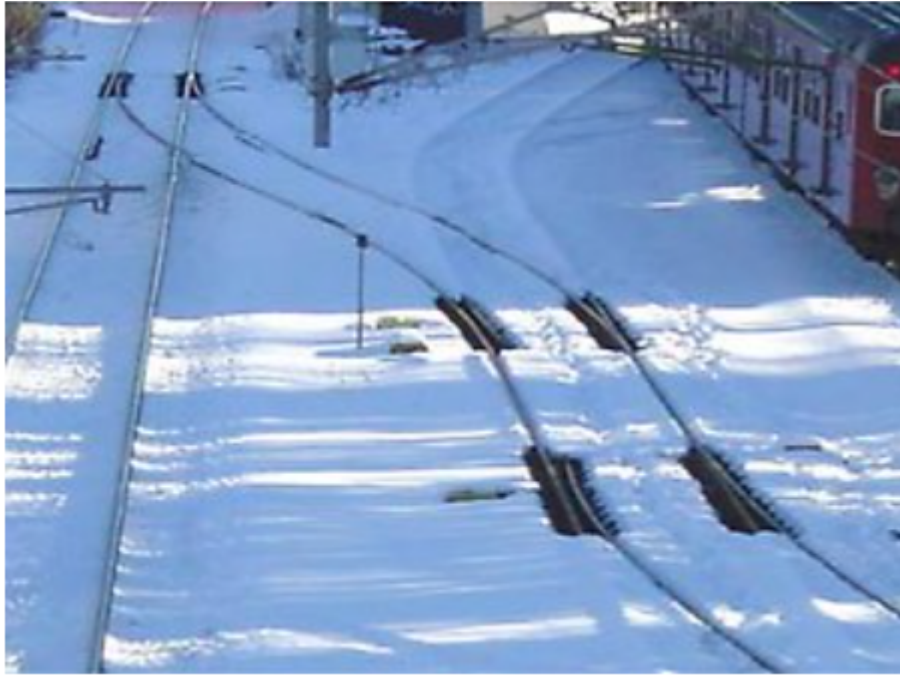
Figur 4 Visar hur en växelvärmare håller växeln fri från snö och is (Nibe Element Railway Solutions, 2021)
