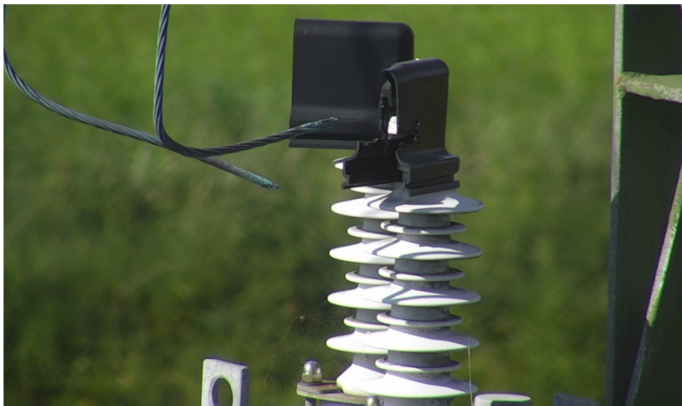
Figur 9 Visar ett foto på en trasig kontaktledning taget med hjälp av en drönare (Bankert, 2020)
