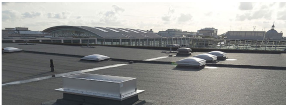
Figur 2.6 Bilden föreställer Derbigums koldioxidabsorberande tätskikt vilket ser ut som ett vanligt pappskikt (Derbigum Sverige AB, 2020).
