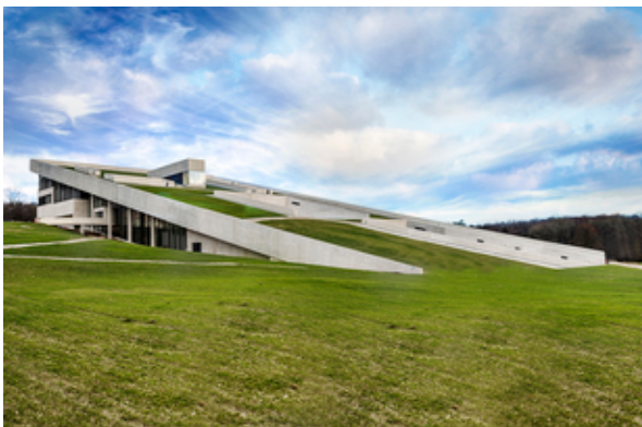
Bild 2. Intensiva grön tak (Vad är extensiva och intensiva gröna tak? u.å.)
