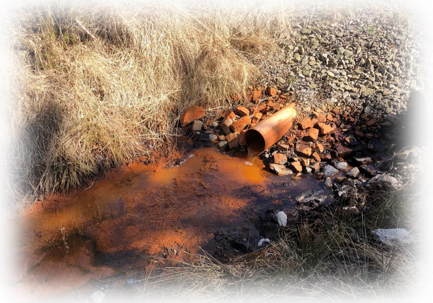
Rödslam som har ansamlats i ett dike vid ett utlopp för läckagevatten. Diket fortlöper cirka 100 m längre, med rödslam som fyller det hela vägen. Bild av Christian Ekström.
