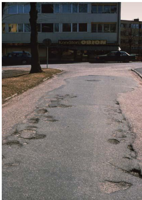
Figur 2–4. Skador vid lagningar av svårighetsgrad 3, där större större ojämnheter, slaghål och krackeleringar har bildats (SKR, 2019).
