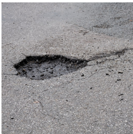
Figur 2–2. Slaghål av svårighetsgrad 3 med en diameter som är större än 20 cm (Götene kommun, 2018).
