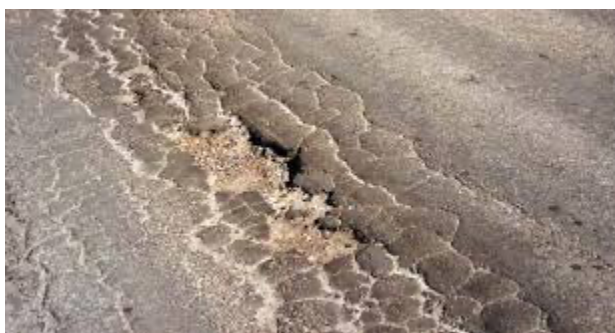
Figur 2–4. Krackeleringar av svårighetsgrad 3 där sprickorna har öppnat upp sig och material har lossnat (SKR, 2019).
