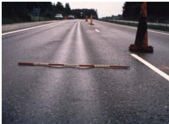
Figur 2–3. Spårbildning på grund av plastiska deformationer (SKR, 2019).
