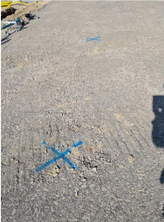
Figur 10. Exempel på ett bärlager. Källa: Egen bild
