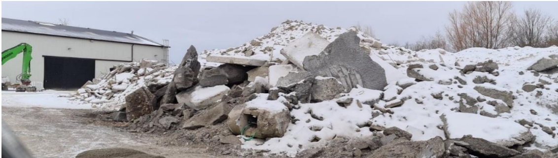
Figur 17. Inkommen rivningsbetong. Källa: Egen bild
