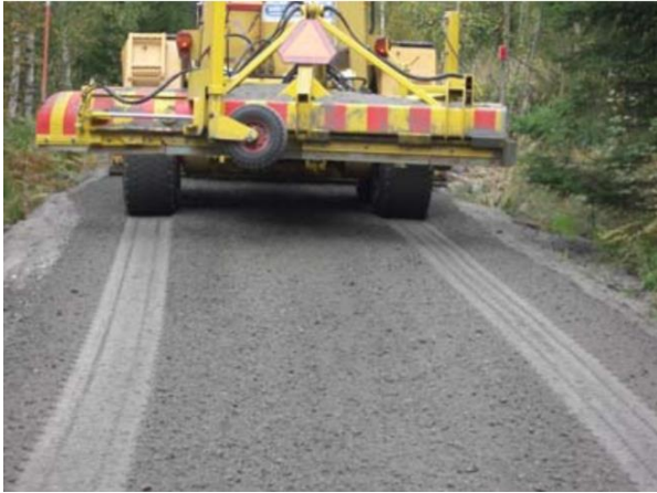
Figur 24. Flygaska i bärlagret på skogsväg. Källa: (SGI, 2006)
