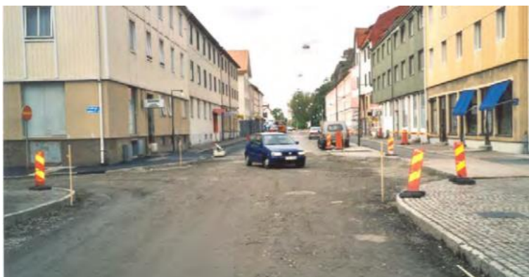
Figur 15. Trafikering av lager med asfaltgranulat innan asfalt läggs på. Källa: (Jacobson, 2002b)
