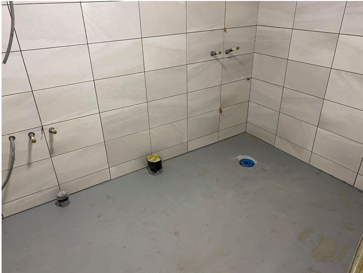
Figur 32 Badrum med kakel på väggen.
