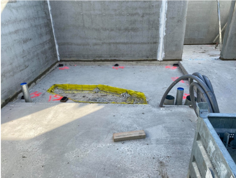
Figur 19 Bjälklaget är förberedd med en ursparning för modulen.
