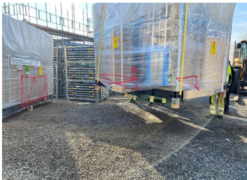
Figur 16 En badrumsmodul lyfts med hjälp av de gula lyftnycklarna.
