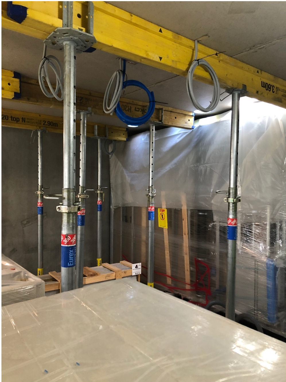
Figur 37 - Bockryggar och stämp stöttar bjälklag på Modulprojektet. Dock inte där badrumsmodulen står.
