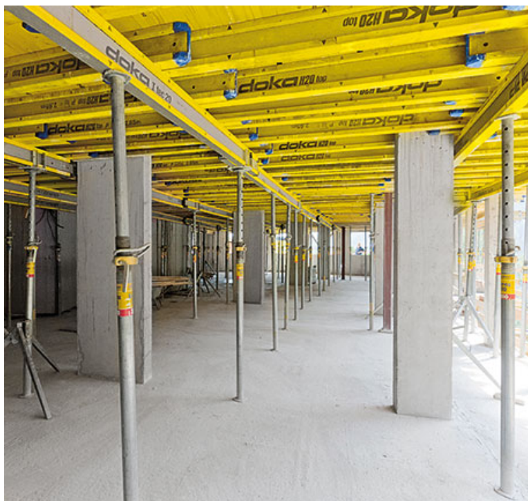
Figur 36 Bockryggar upplagda på stämp stöttar bjälklaget under tiden som betongen på bjälklaget ovanför härdar (Doka, u.d.)
