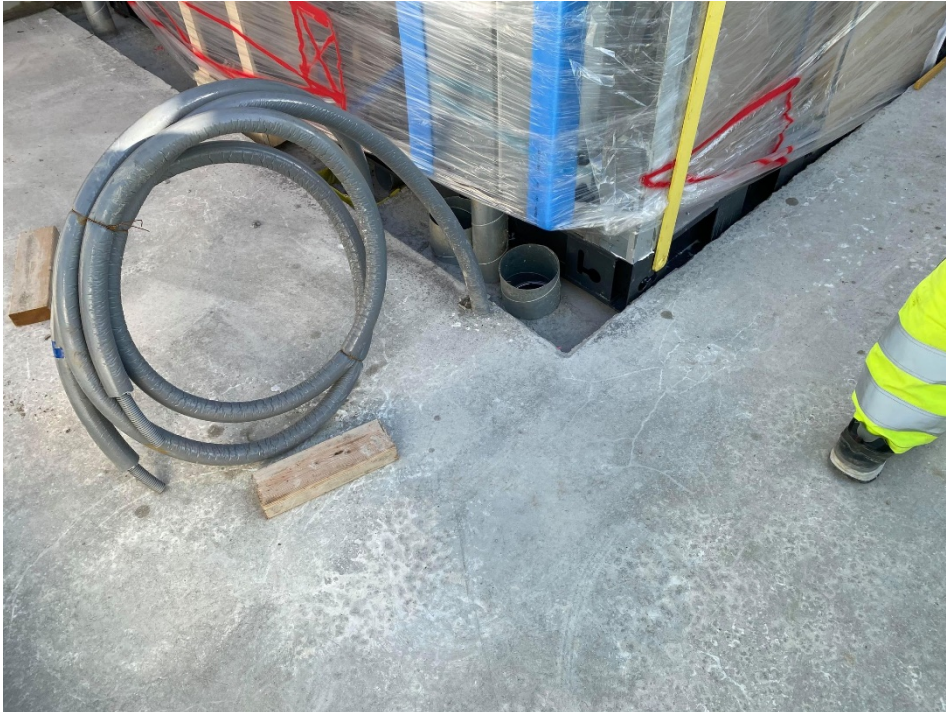
Figur 21 Stosar och andra installationer syns intill modulen där schaktet senare kommer byggas.
