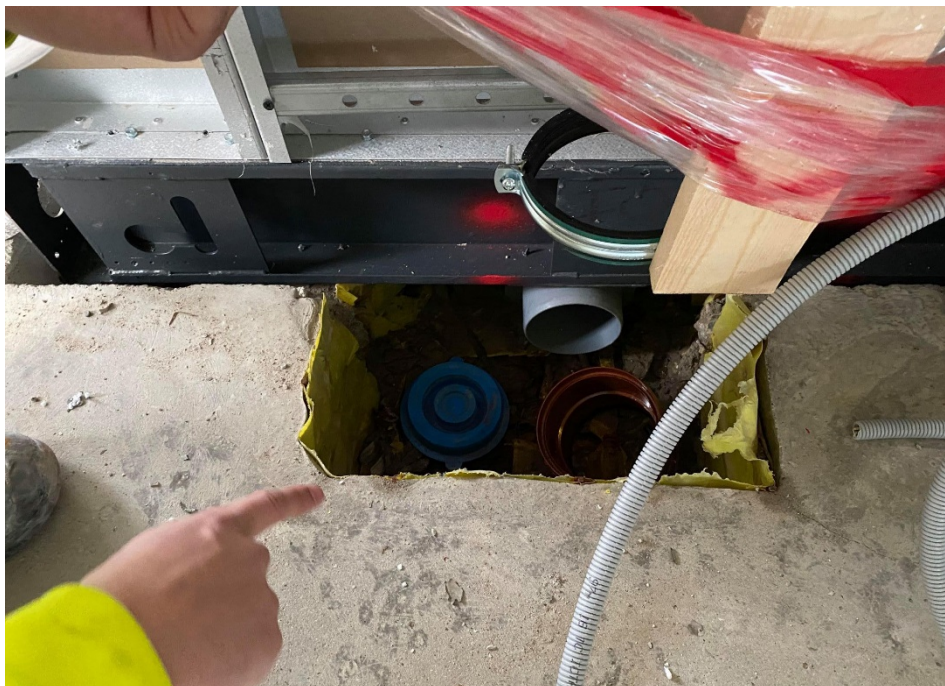
Figur 22 Avloppsrören i schaktet som ska kopplas samman med modulens avloppsrör.
