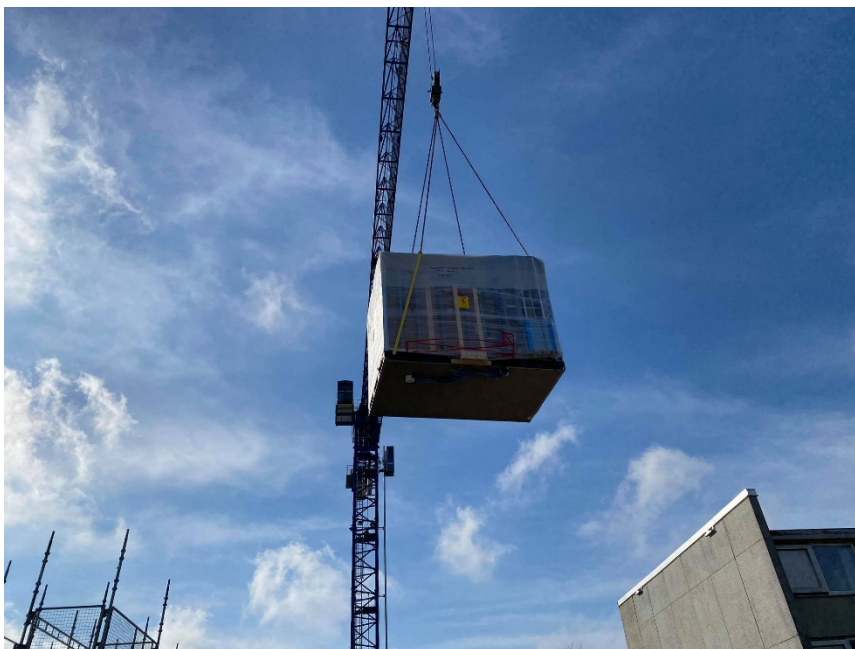
Figur 18 Modul lyfts med kranen till rätt lägenhet.
