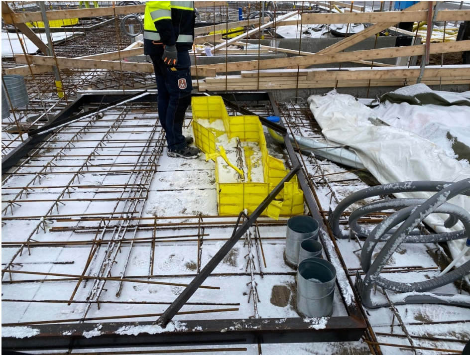
Figur 13 Ventilationsrör krockar med ramen för ursparningen (högt upp i bild). Tre stosar för vattenrör syns i bildens nederkant.
