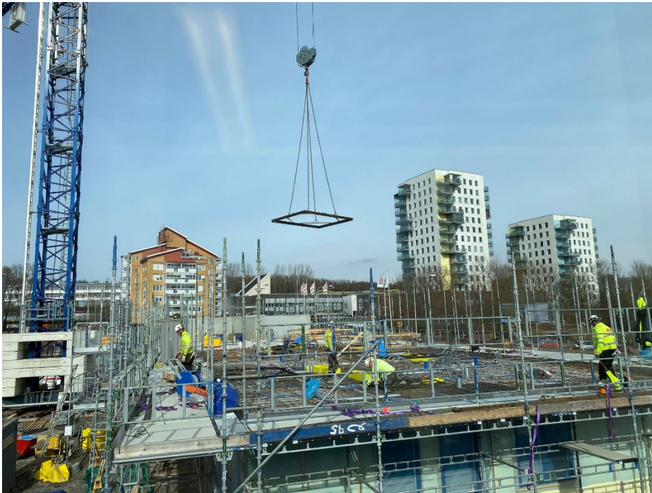
Figur 23 En form till bjälklagets ursparning flyttas med kran.
