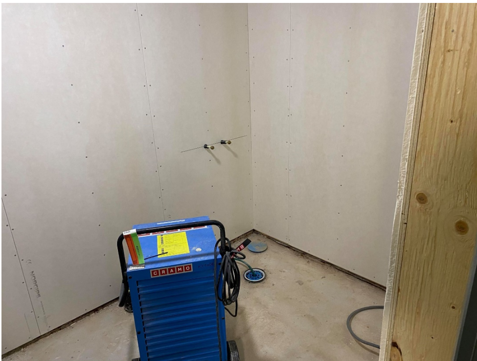
Figur 30 Badrum kompletterad med våtrumsgips i hela rummet. Avfuktare fuktar av rummet.
