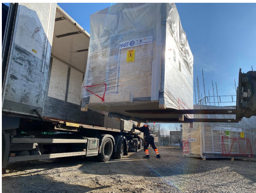
Figur 15 En badrumsmodul lyfts av från lastbil.
