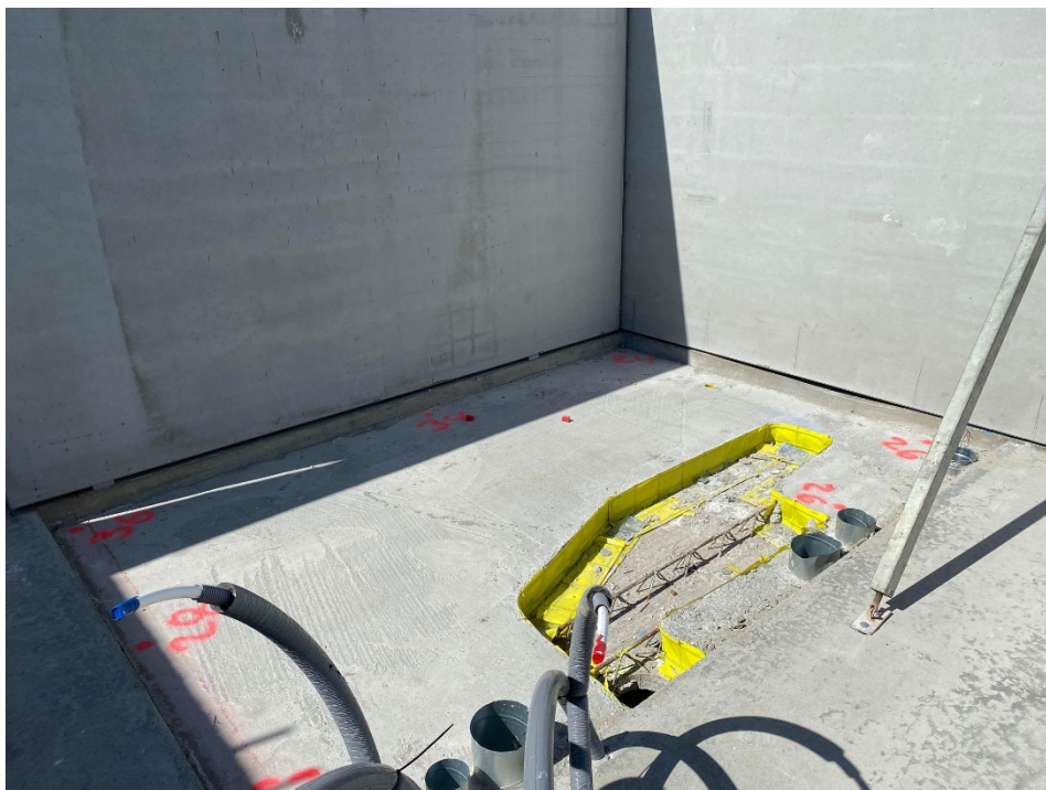
Figur 14 Ursparning med synliga armeringsstegar.
