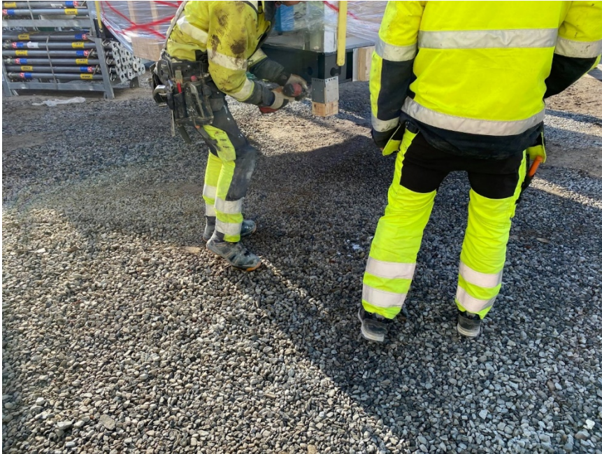
Figur 17 Stödbenen skruvas bort från modulen.
