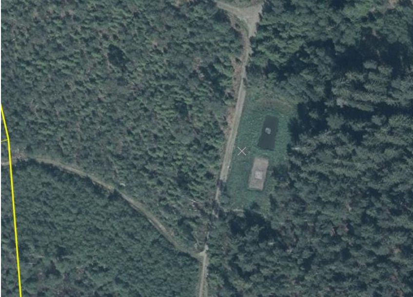
Figur 20 Flygbild över den gemensamma avloppsanläggningen (Lantmäteriet KSO 2021)
