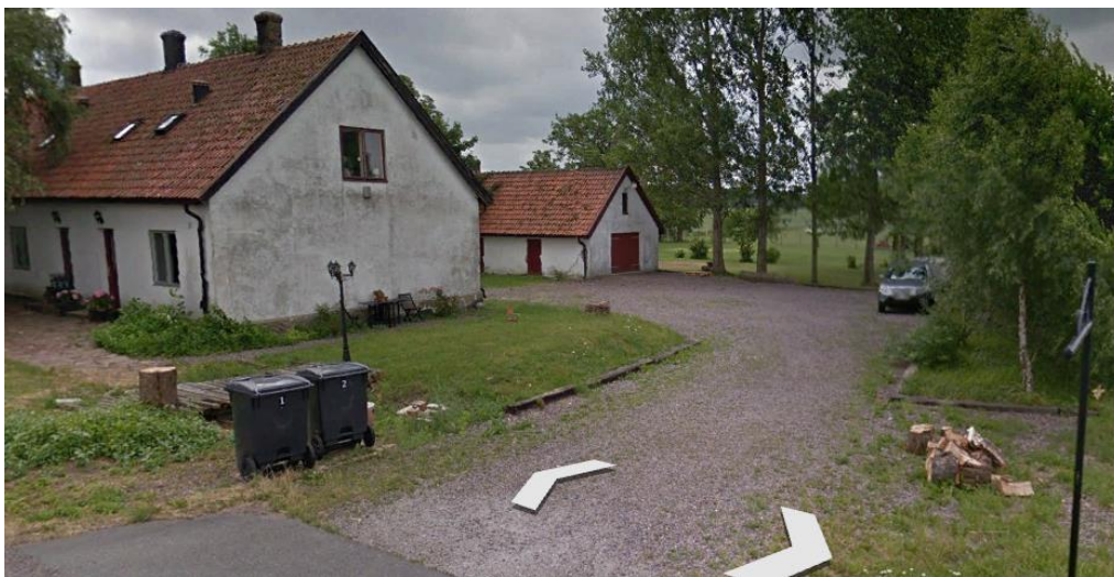
Figur 37 Byggnad med gemensam utfart, parkering och förråd. (Google Maps 2021)
