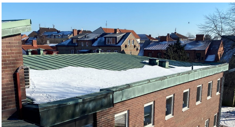
Figur 3.8 Sadeltaket av plåt på 60-tals byggnaden med en lutning på 14°. Riktning nordöst och sydväst. Bild tagen av Alexandra Bernardo.
