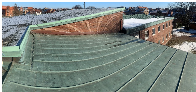
Figur 3.16 Ett av pulpettaken på mellanbyggnaden med en lutning på 6°. Riktning sydöst. Bild tagen av Diana Kron.
