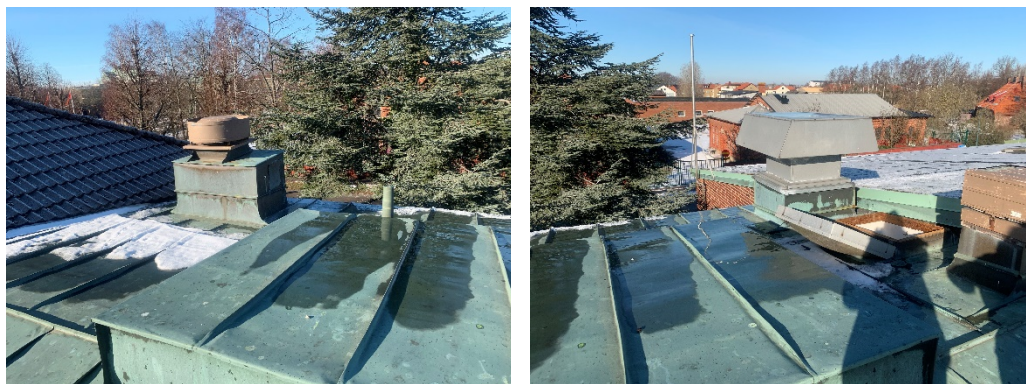
Figur 3.15 Ett av pulpettaken på mellanbyggnaden med en lutning på 6°. Här finns luckan upp till taket, dessutom en del huvar för ventilationssystemet i 80-tals byggnaden. Riktning nordväst. Bilder tagna av Alexandra Bernardo.
