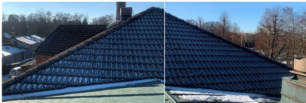
Figur 3.13 Sadeltak av tegel på 80-tals byggnaden med en lutning på 25°. Riktning nordväst och sydöst. Bild tagen av Alexandra Bernardo.
