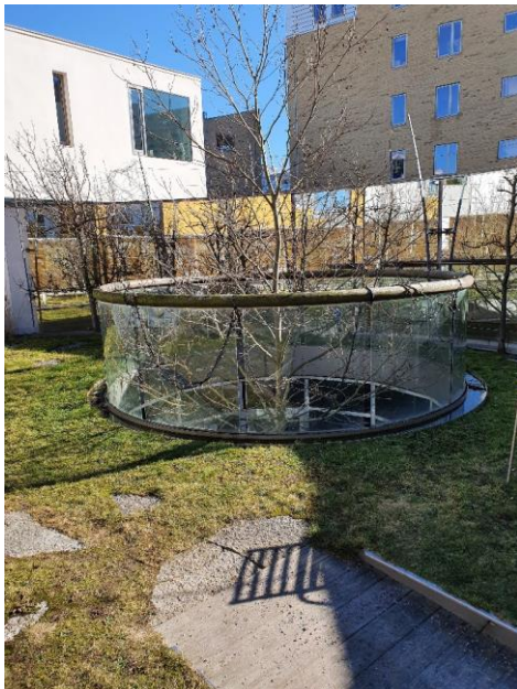
Figur 20 Schakt ner till garaget med ett träd i mitten på Kajplats 01.
