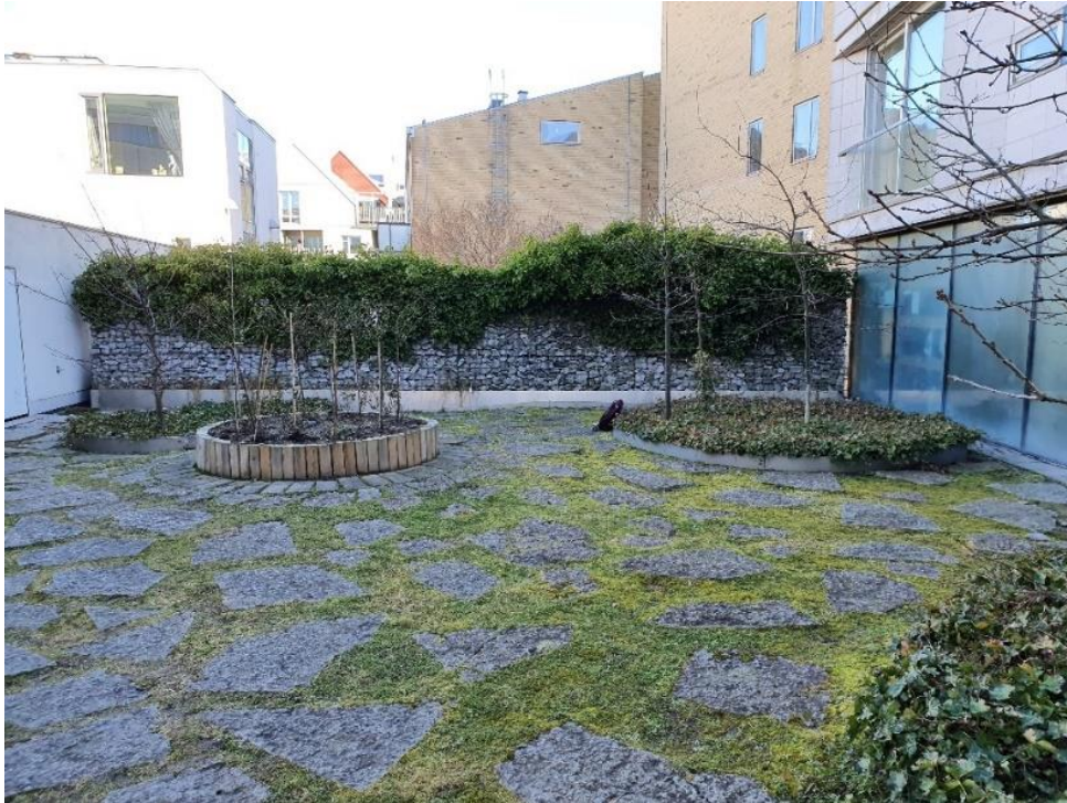
Figur 18 Glest lagda stenar, upphöjda planteringar och mur med växtlighet på Kajplats 01.
