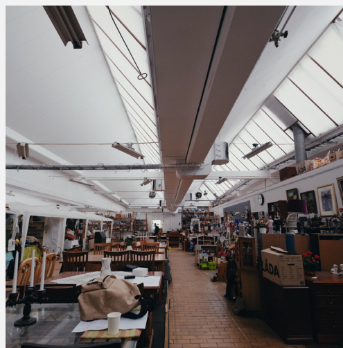
Stora takfönster mot norr i byggnaderna i Väveriet.
