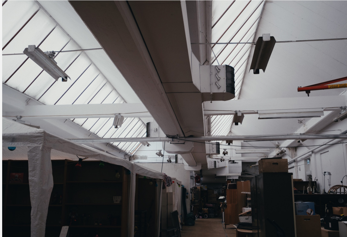
Jag har valt att bevara så många takfönster som möjligt för att minna om byggnadernas historia som arbetsutrymmen, och för att behålla det fantastiska ljusinsläppet.
