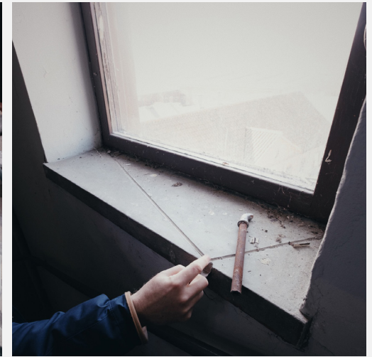
Gammal ränna för avrinning av kondens på fönstren i Fabriken.
