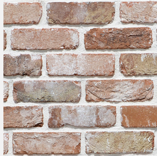
Återbrukat tegel i en ljusare kulör används vid alla tillagda yttreväggar och får även synas på insidan.
