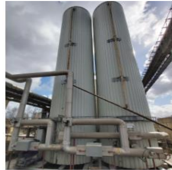
Figur 11: Isolerade tankar för lagring av bindemedel
