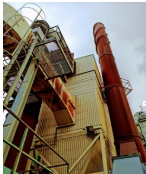
Figur 10: Filterhus med ingående rökgasledning
