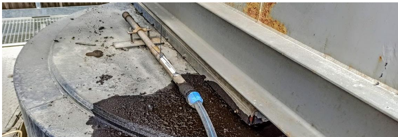
Figur 5: Spridarsystem för förnyngsmedel på Dalby asfaltverk.
