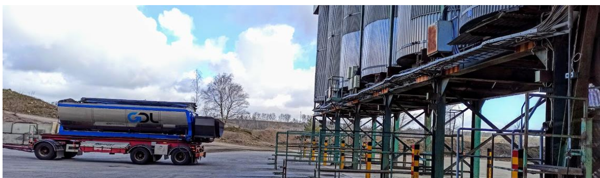
Figur 14: Upphämtning av asfaltmassa från isolerad lagringsficka.
