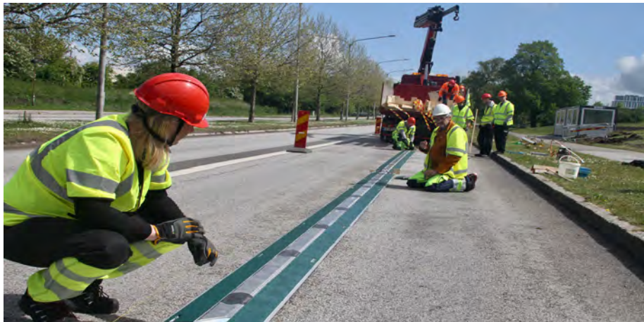
Figur 3: Elonroads elväg i Lund. Exempel på konduktiv elväg där en släpkontakt ska släpa på en skena för att skapa en elektrisk kontakt. Bild hämtad från ElonRoads hemsida. [8]
