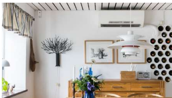
Luftvärmepump i köket.
