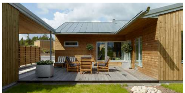
(Foto: Svensk Byggplåt, 2010) Insynsskyddad uteplats.
