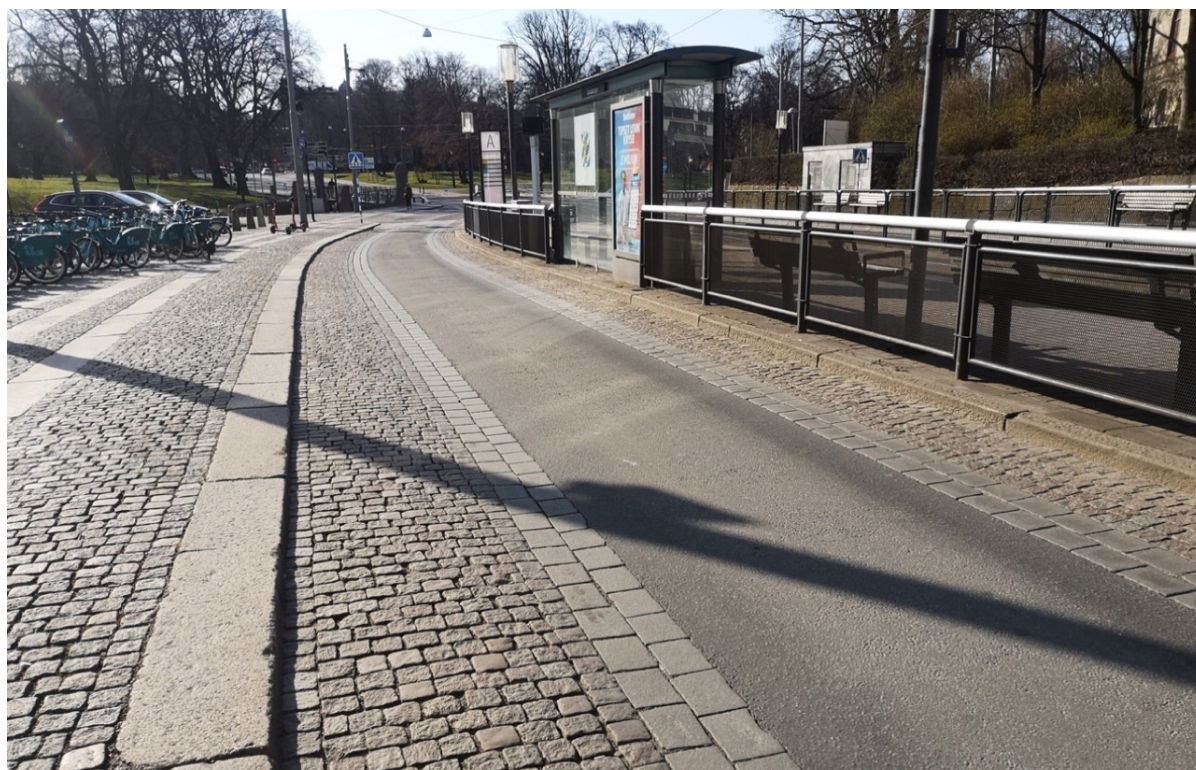
Figur 12. Cykelgatan på Västra Hamngatan i Göteborg. Körfält av asfalt och gatsten på sidorna. Foto: Klara Skalare.
