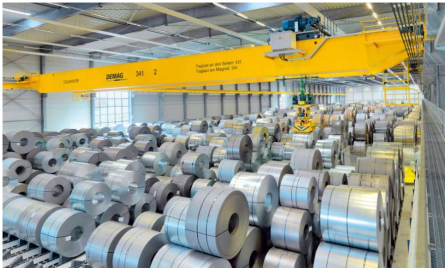
Overhead crane, (Demagcranes, 2021)
