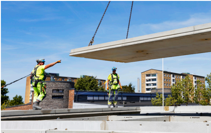
Figur 6: Bild på montage av massivbjälklag (Finja Prefab, 2020)
