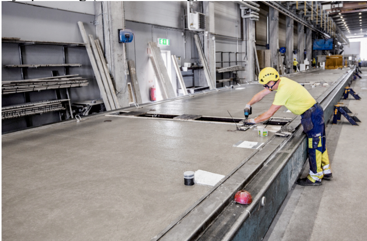
Figur 4: Bild på tillverkning av massivbjälklag i fabrik (Finja Prefab, 2020)
