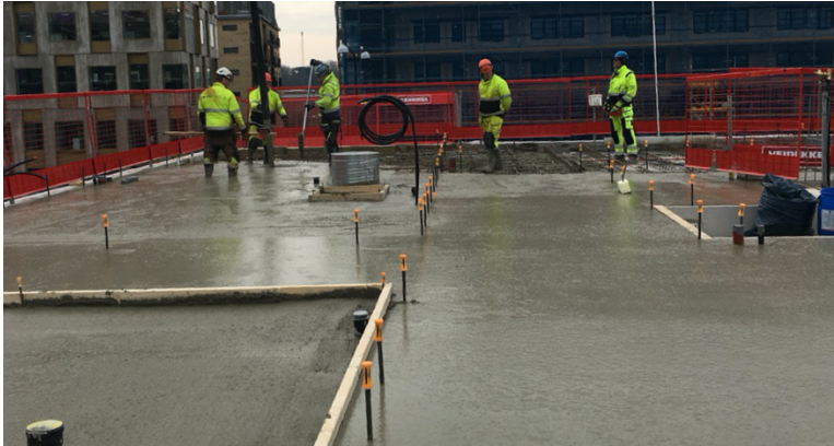
Figur 8: Bild på gjutning av plattbärlag på fallprojektet
