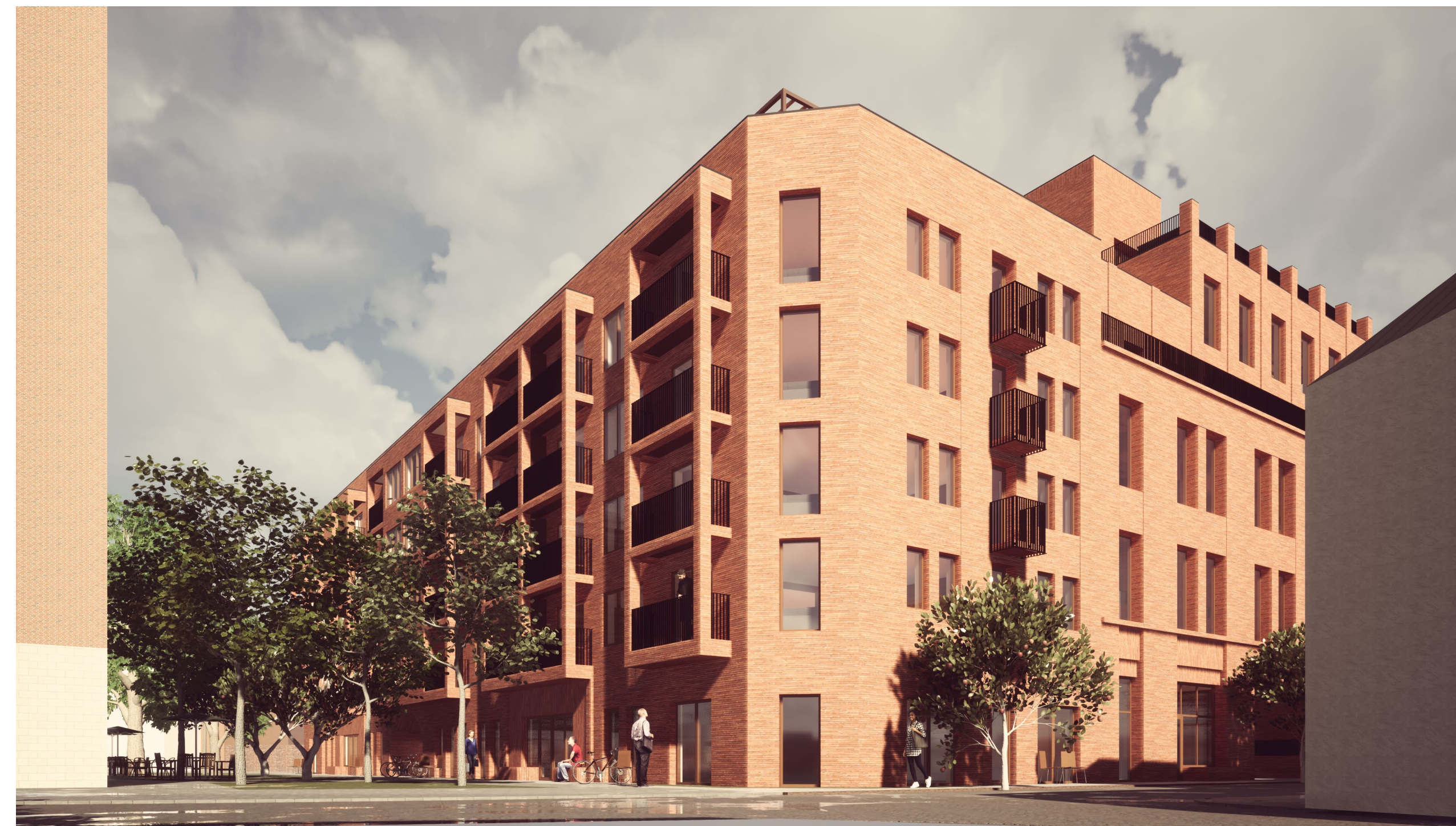
Hörnet på bostadsvolymen mot gränden. Hörn som riktar sig utåt bildar tydliga ansikten mot sin omgivning. Ett mellanting mellan de vinkelräta sidorna. De inramade balkongerna vänder sig mot den nyare bebyggelsen och refererar burspråken på intilliggande byggnad samt bostadshus längs med Karl XI:s väg, foto på sida X. De små "paradbalkongerna" är till för att visa om den invändiga funktionen, som övergår från kontor till bostäder.
