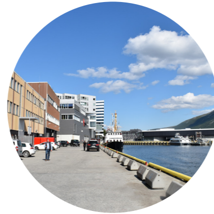
Stora delar av centrums kustlinje består främst av betongkajar
