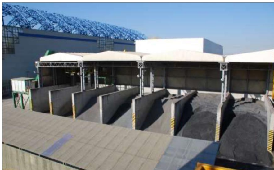
Figur 6-5. Mellanlagring av returafalt delvis under tak i separata högar (Brian, 2014).
