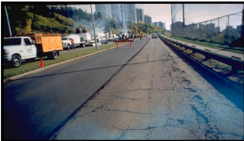
Figur 3-13. En jämförelse av en beläggning före och efter återvinning på plats (Kandhal & Mallick, 1997)
