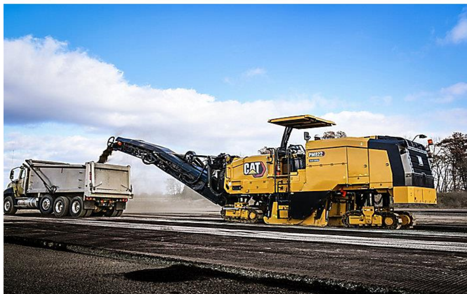
Figur 3-1. Kallfräsning (planfräsning) av asfaltbeläggning (CAT, 2021). Copyright (2021) med tillstånd från CAT Copyright Agent.
