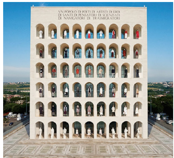
Figure 12. Palazzo della Civiltà Italiana after Fendi moved in.
