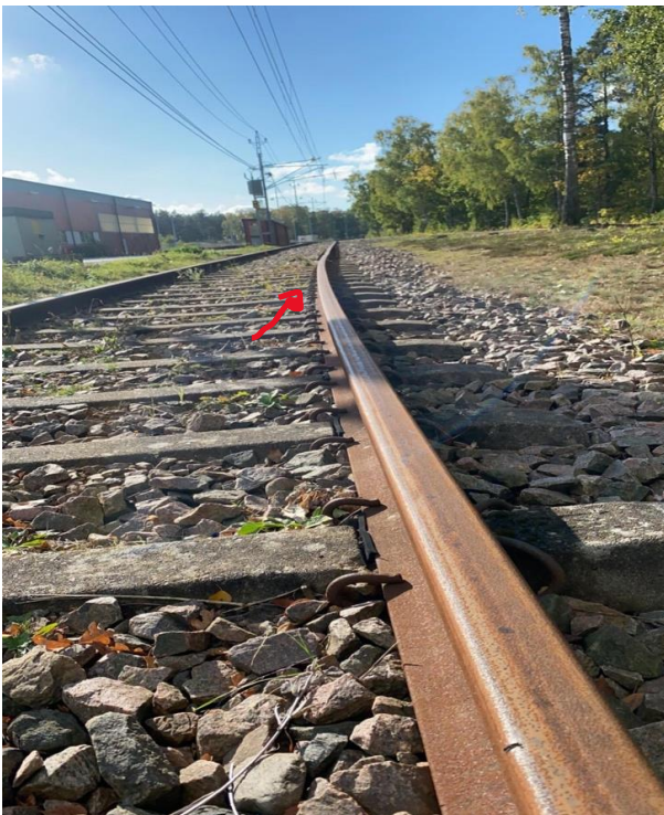
Bild 12. Bilden visar att ju längre fram man kommer så buktas det. Sedan uppstår det ett sidolägesfel vid pilmarkeringen samt ett höjdlägesfel.
