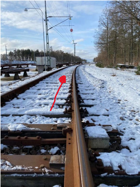
Bild 16. Bilden visar ett sidolägesfel.
