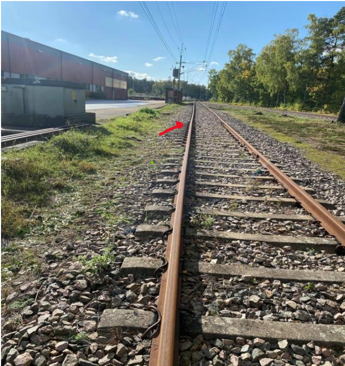
Bild 11. Visar att de finns nivåskillnad i rälen, bilden visar en liten svacka sedan en förhöjning.
