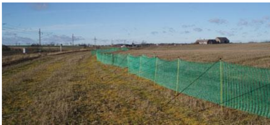
Figur 4.1.2.1.4: Snöstaket som ska skydda mot drivbildning på banvallen / (Trafikverket, 2018)
