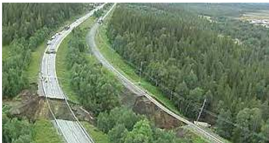
Figur 4.1.1.1: Jordskred i Jämtland 2006, delar av E18 som rasade / (SVT, 2006)
