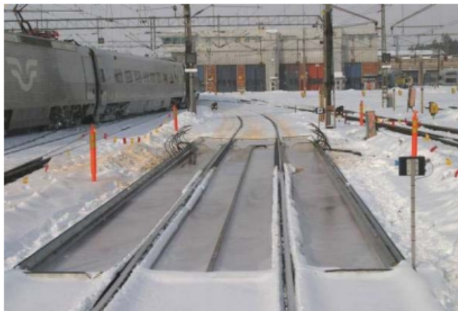
Figur 4.1.2.5.3: Glykol avisningsanläggning i Hagalund / (Kloow, L; 2011)
